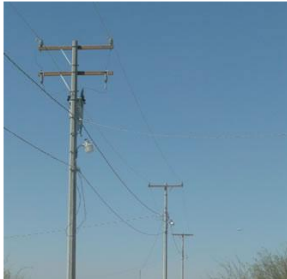
Figura 1. 5 Sistema de distribución de 13.8 kV.
