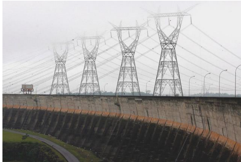
Figura 1. 4 Sistema de transmisión de 500 kV.
