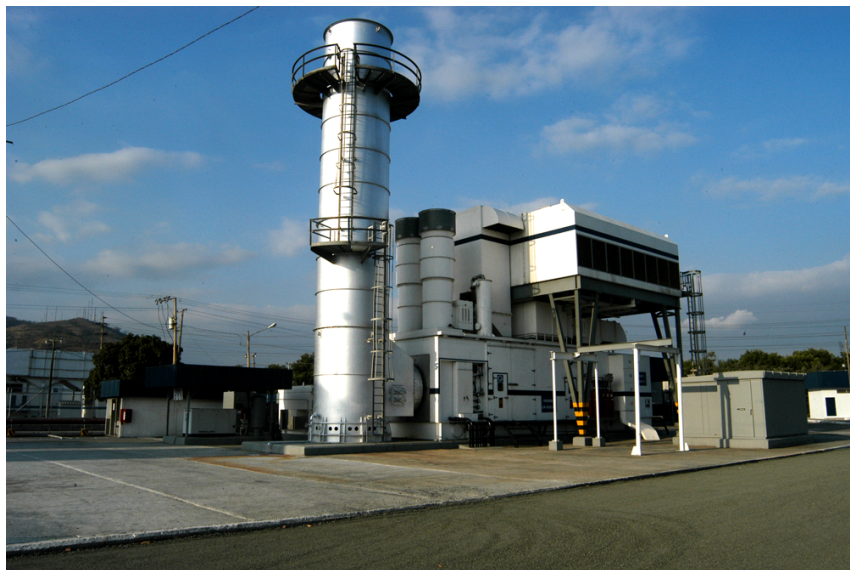
Figura 1.3 Turbina a Gas Nº 1 LM6000
