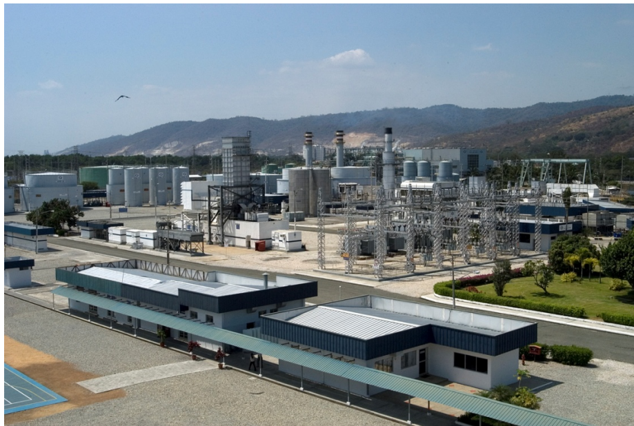
Figura 1.1 Vista de la Central Térmica Álvaro Tinajero
