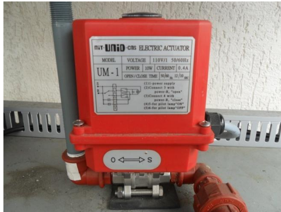
Figura 22.- Actuador eléctrico para válvula.
