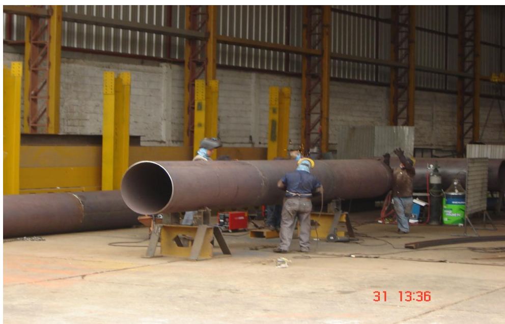
Figura 1.1.15 Soldado de tubos
