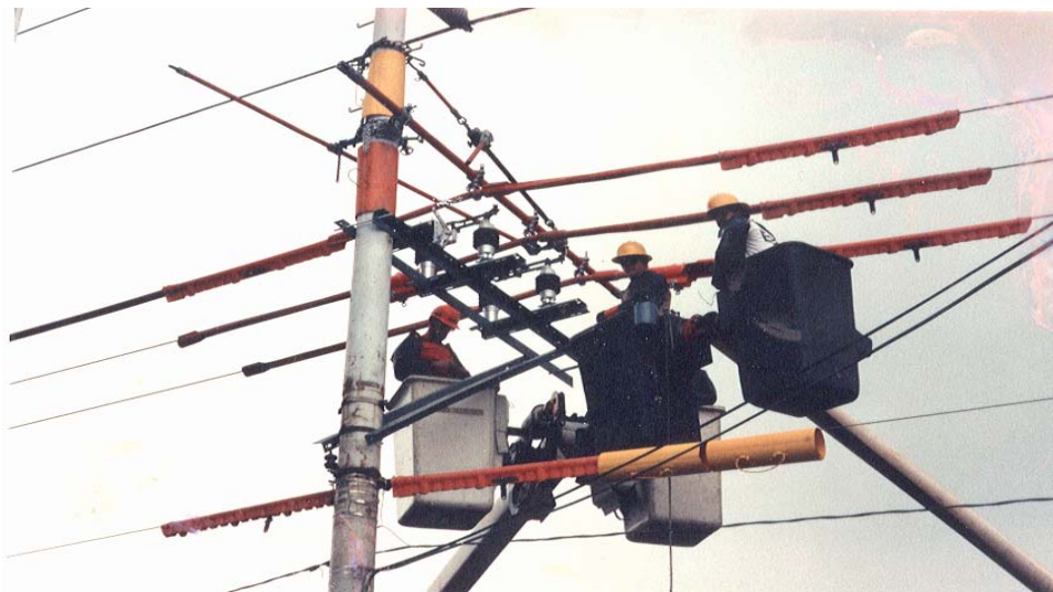
Trabajos con líneas Energizadas ( Instalación de un interruptor de 600 amperios 15 kv). Figura 2
