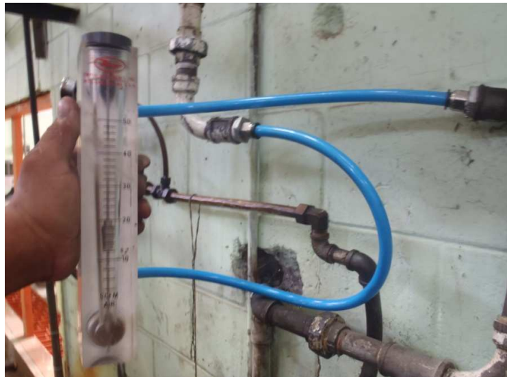
FIG. 2.16 MEDICIÓN EN EL ÁREA DE LA TERMOFIJADORA
