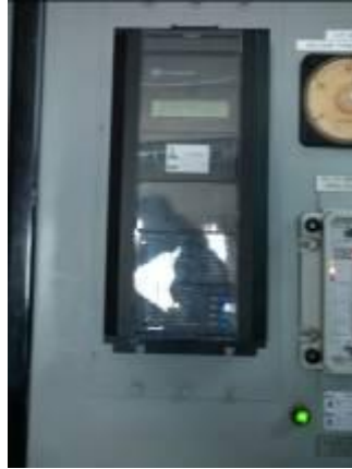
Fig.1.VII. RELE D60 GE
