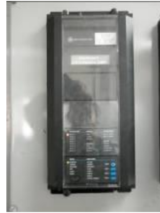
Fig.1.X. RELE D30 GE POSORJA
