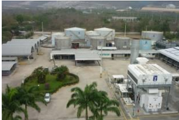
Fig.1. II. Planta Electroquil Generador
