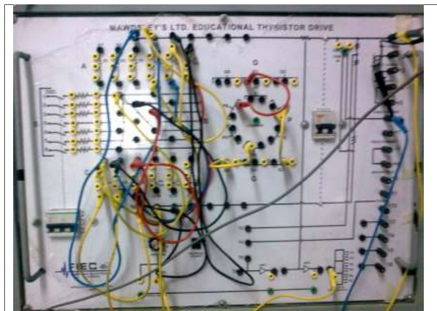
Figura 2.12 Imagen de las conexiones del rectificador trifásico controlado, conducción continua con diodo de paso libre ( R=100\text{ ohm} , L=242\text{mH} , \alpha_F = 60^\circ )
