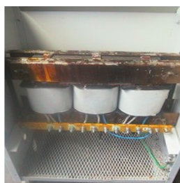
Figura 1.2. Transformador trifásico tipo seco
