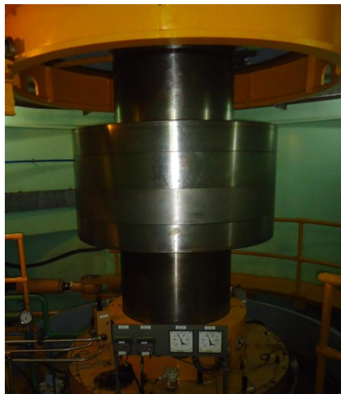
Figura 1.4 Acople Turbina-Generador.
