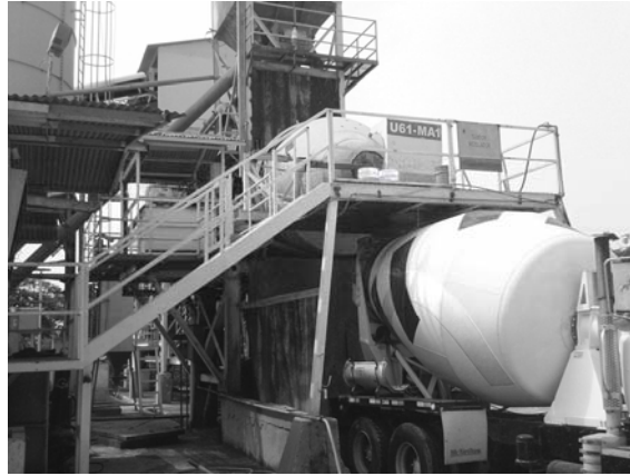
Figura 2. Hormigón vaciado de planta al carro transportador
