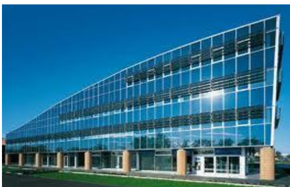
Figura 26.- Edificio con paneles fotovoltaicos como fachada
