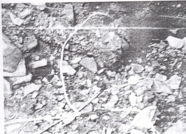
FIGURA 3.1. Conexiones y aislamientos de cables antes de ser cubiertos con material pétreo.
