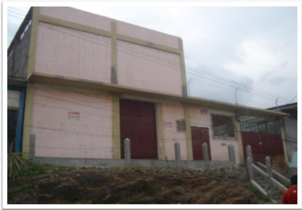
Figura 11. Parte exterior del local B
