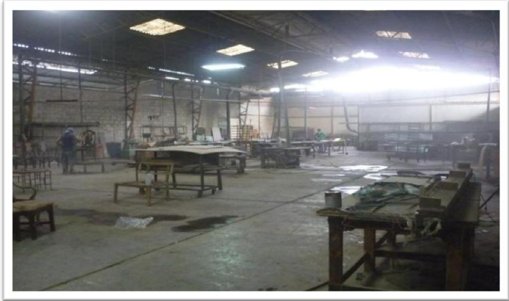
Figura 12. Parte interior del local C
