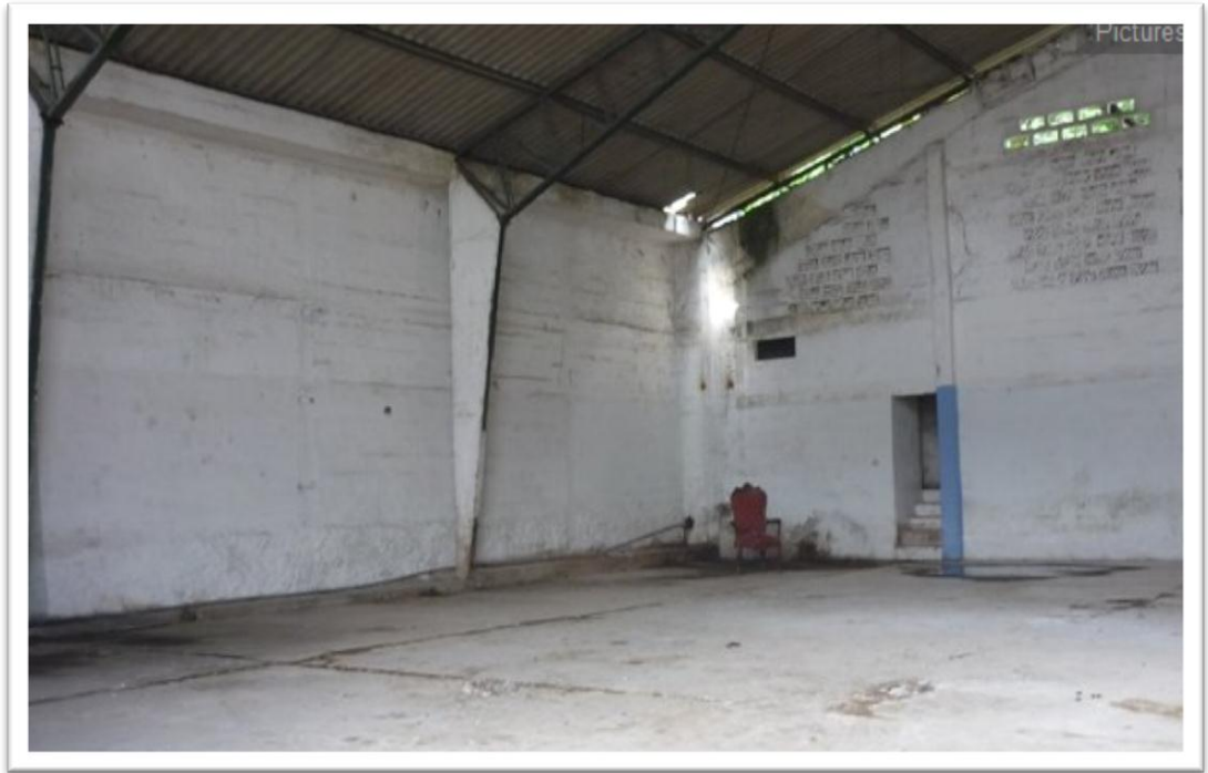
Figura 9. Parte interior del local A
