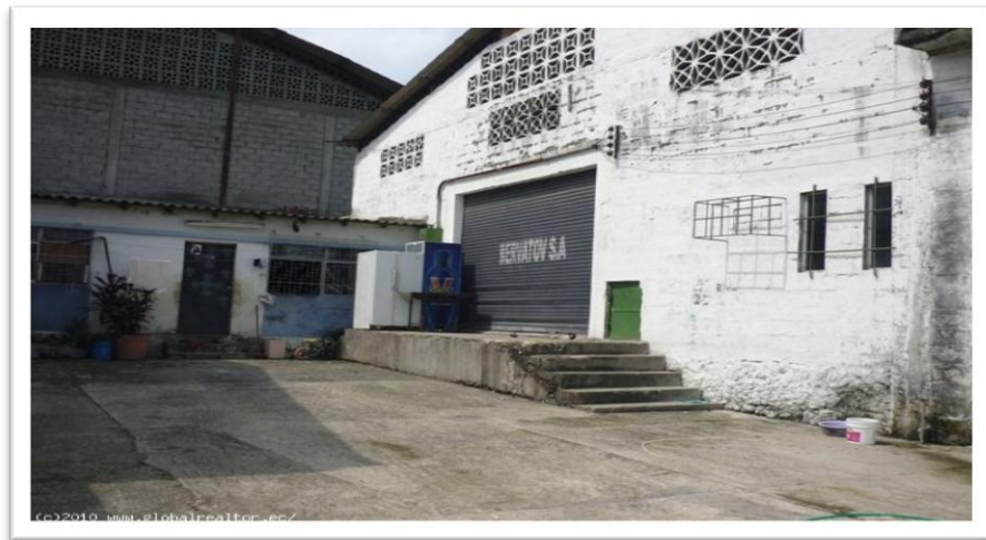
Figura 8. Parte exterior del local A
