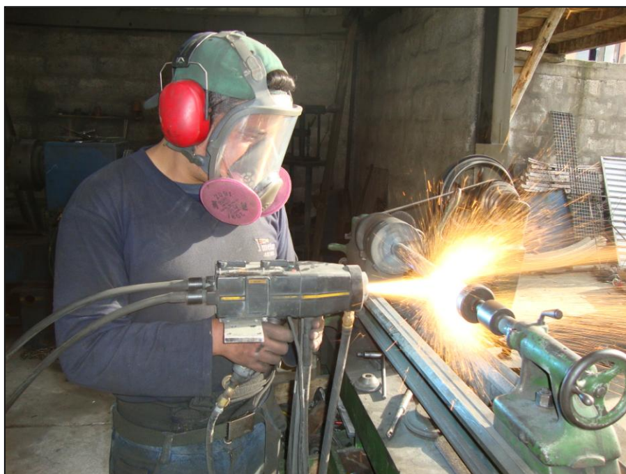
Figura 3.15: Aplicación del alambre final 60T
