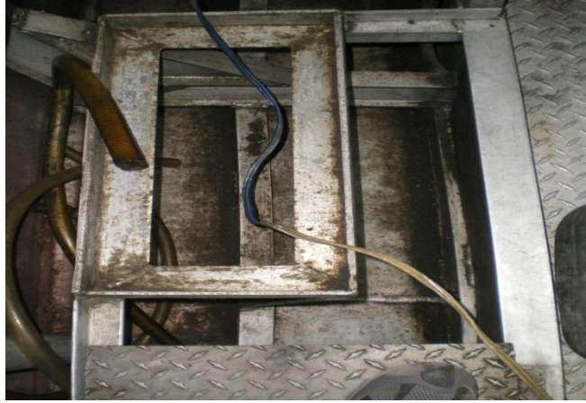
FIGURA 1.5 VISTA INTERNA DEL FONDO DEL CASCO
