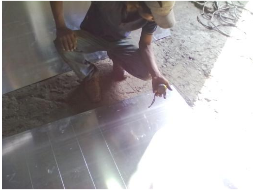
Figura No. 16 Medición de estructurales y trazado sobre planchas
