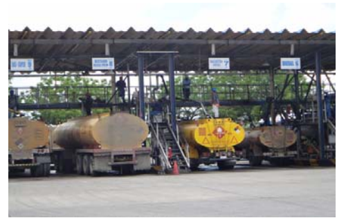
ÁREA PRINCIPAL DE LA PLANTA (ISLA DE CARGA)
