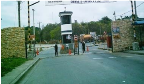
GARITA No. 1. ENTRADA A LA PLANTA
