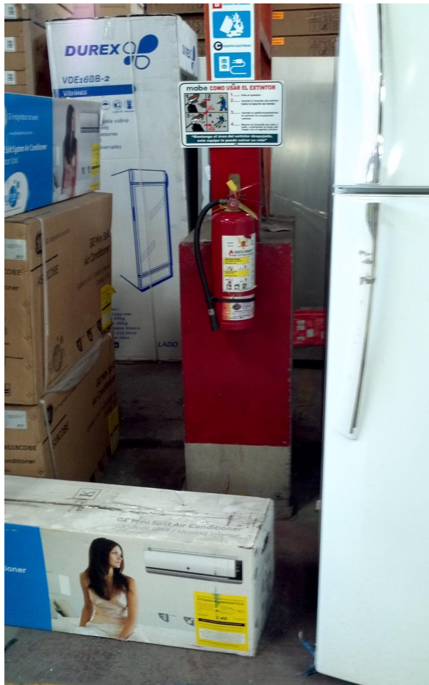
FIGURA 3.2.- ALMACENAMIENTO INAPROPIADO DE PRODUCTOS
