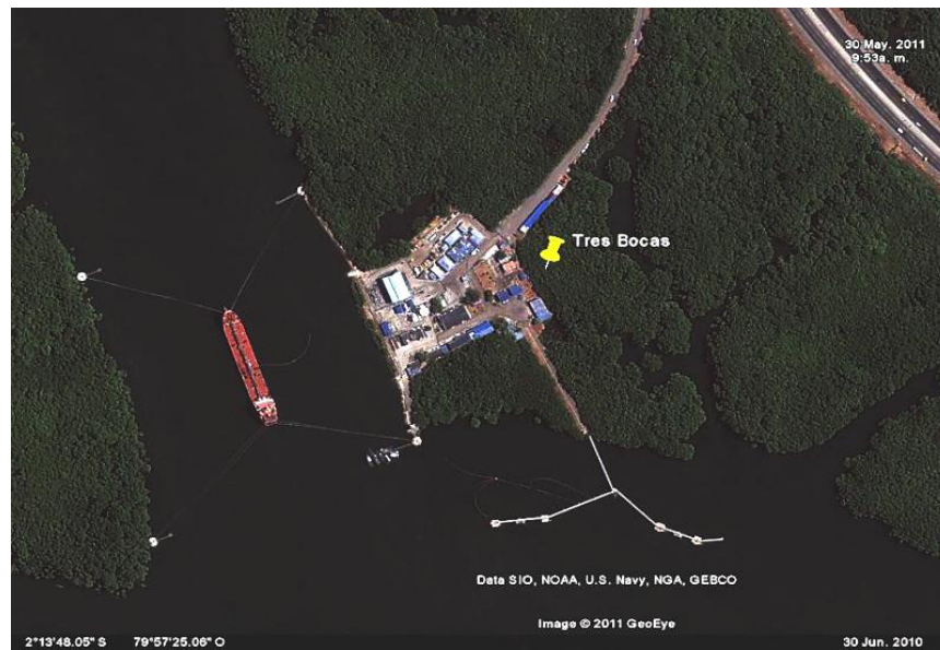
Figura 2.1.- Vista Panorámica Satelital de la Terminal Tres Bocas.
