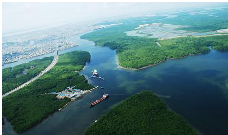
Figura 2.2.- Vista aérea del Terminal Tres Bocas
