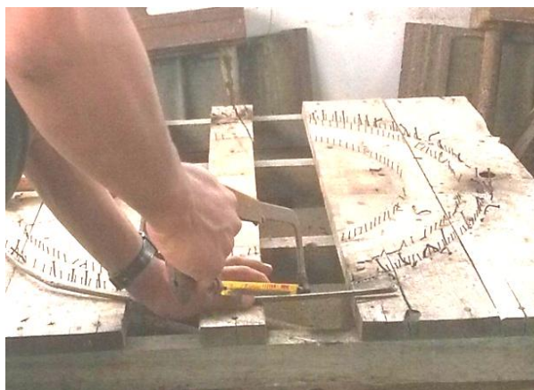
Figura VI. Cortado de varilla 17 .
