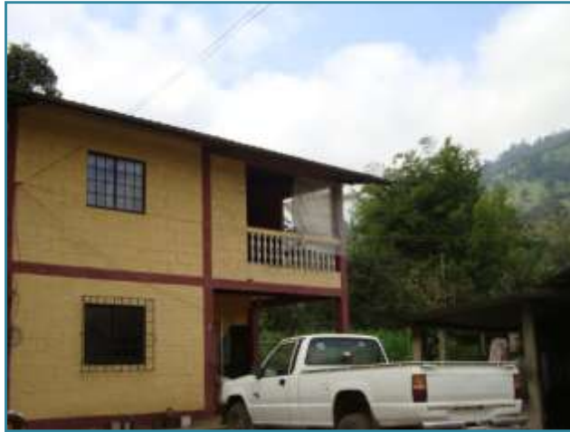
Edificio de ingreso la hacienda La Nathalia (comedor-cocina, servicio sanitario, oficina y bodega)
