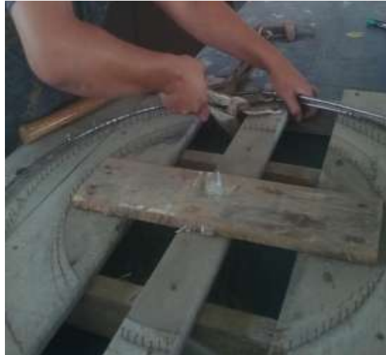
Figura XV. Moldeado de las varillas de hierro
