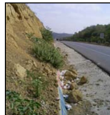
Figura 4.4.1 Vista parcial base del Talud No. 9, Abscisa 37+359
