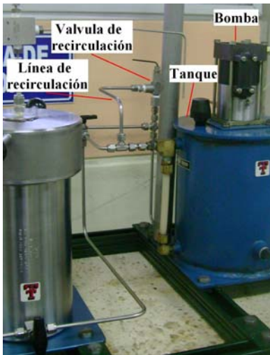
Figura 6. Línea y válvula de recirculación
