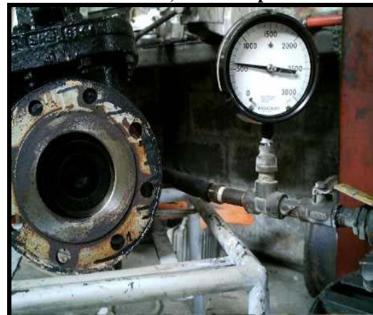
FIGURA No. 14 SISTEMA DE BANCO DE PRUEBA A 3445578,23 Pa/500 psi
