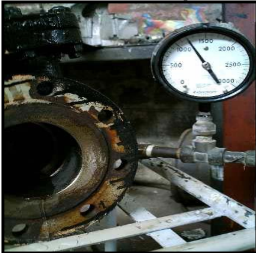
FIGURA No. 16 SISTEMA DE BANCO DE PRUEBA A 8269387,76 Pa. / 1200 psi
