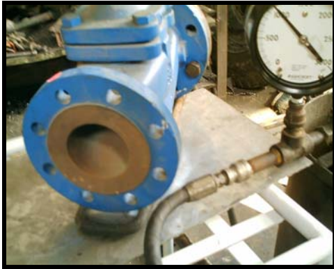
FIGURA No. 19 SISTEMA DE BANCO DE PRUEBA A 6891156,46 Pa. / 1000 psi
