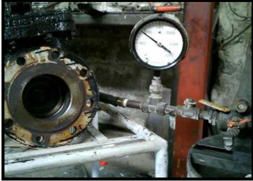
FIGURA No. 15 SISTEMA DE BANCO DE PRUEBA A 6891156,46 Pa. / 1000 psi
