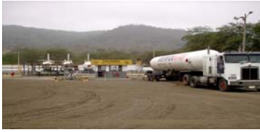
Figura 2 Área de descarga de autotanques
