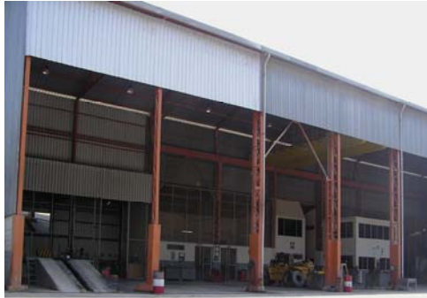
FIGURA 2.1 TALLER MECÁNICO PARA REPARACIÓN Y MANTENIMIENTO
