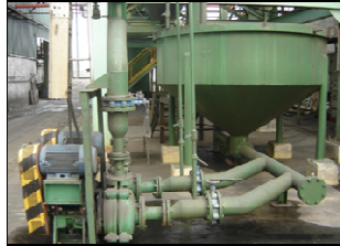
Figura 10. Tanque de lodos.
