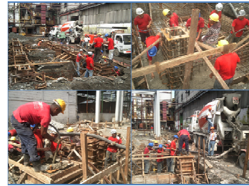
Figura 13. Trabajos de vaciado de hormigón.
