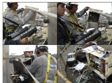
Figura 29. Monitoreo de gases de combustión de las calderas
