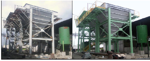
Figura 25. Sistema antes y después de pintura.
