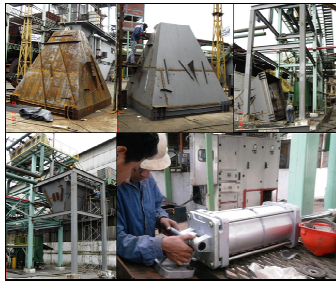
Figura 19. Construcción y montaje de tolva recolectora de ceniza.
