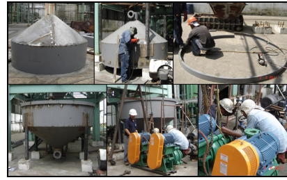
Figura 22. Construcción de tanque de lodos.
