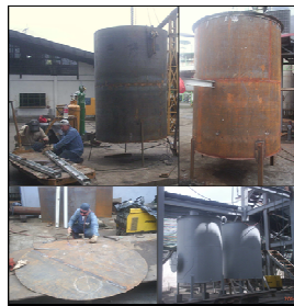
Figura 21. Construcción de tanques de floculante.
