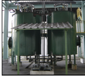
Figura 9. Estación de floculante.
