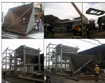
Figura 16. Montaje de celdas de decantación.
