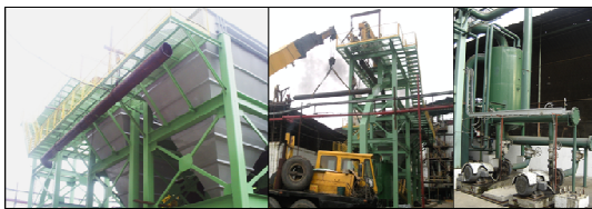
Figura 26. Instalación de tubería de interconexión.
