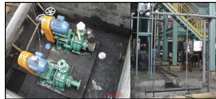
Figura 23. Montaje de bombas y tuberías de tanque de drenos.
