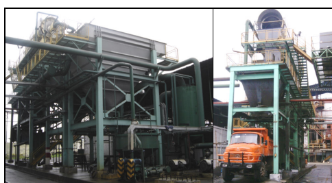
Figura 28. Nuevo sistema de clarificación de agua con ceniza en plena operación.
