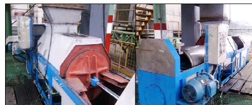
Figura 18. Instalación de prensa desaguadora.
