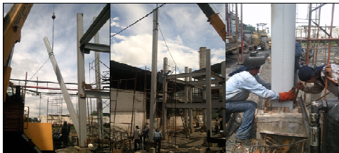
Figura 15. Construcción de estructuras
