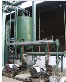
Figura 11. Tanque de agua tratada.
