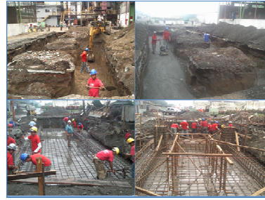
Figura 12. Trabajos de excavación, compactación, armado de hierros y encofrado
