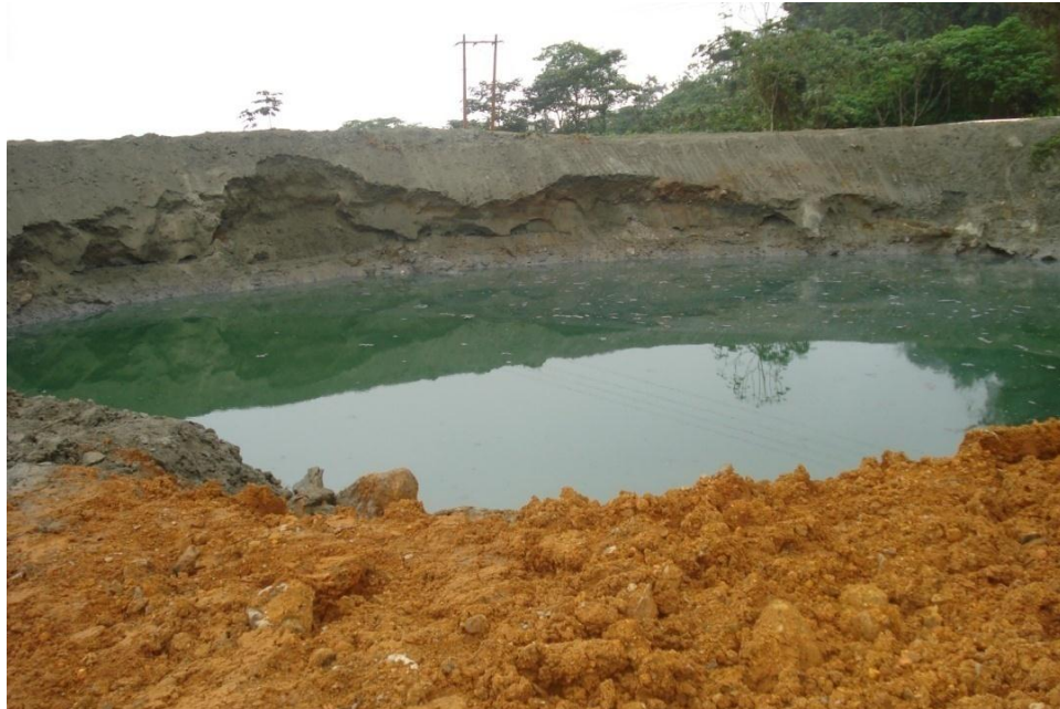
Figura 5.7 Relavera situada en el sector de La López, la cual tiene protección arcillosa para almacenar colas mineras. Fuente: Galarza, B., Valverde, P., 2011.
