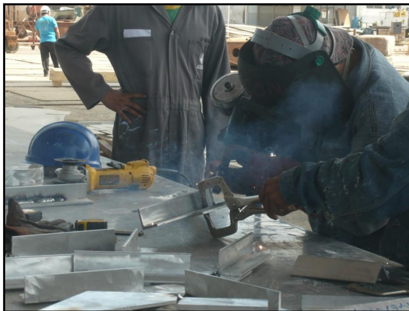
Figura No. 25 Soldadura de cada conexión estructural
