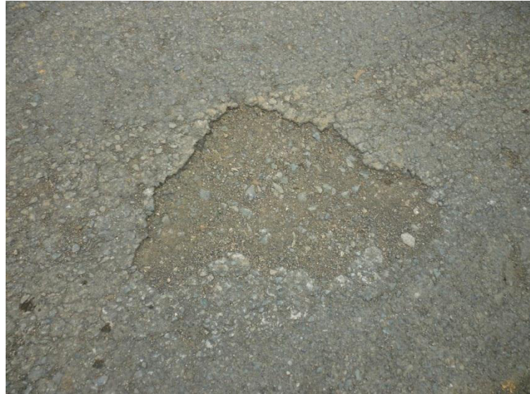
Gráfico 2.3. Pérdida de Agregados en Pavimentos Flexibles.
