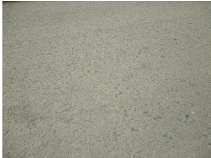
Gráfico 2.6. Desgaste de los Áridos.
