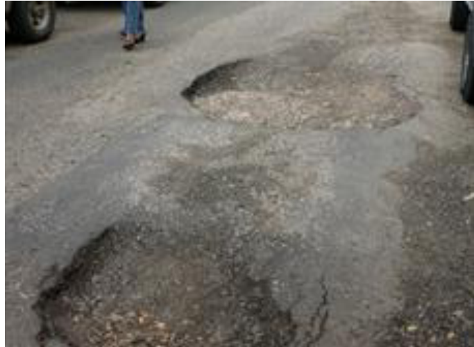
Gráfico 2.4. Pérdida de la Carpeta de Rodadura. Fuente: http://www.eluniverso.com/2013/03/14/1/1550/lluvias-dejan-grandes-baches.html .
