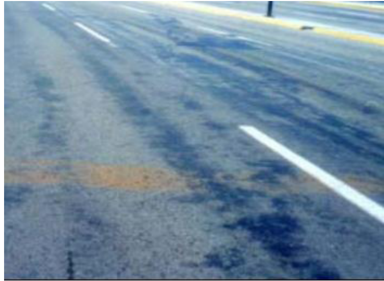
Gráfico 2.5. Exudación del Ligante. Fuente: Catálogo de deterioro de pavimentos flexibles.
