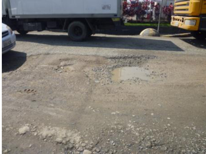
Gráfico 3.4 Estado Actual del Pavimento desde abscisas 0+000 hasta 1+120.
