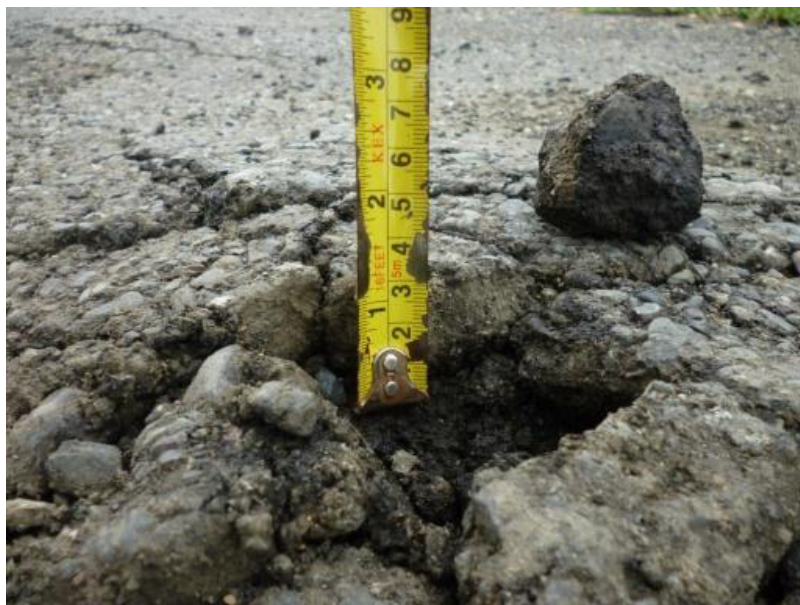
Gráfico 3.6. Estado Actual de la Carpeta Asfáltica.
