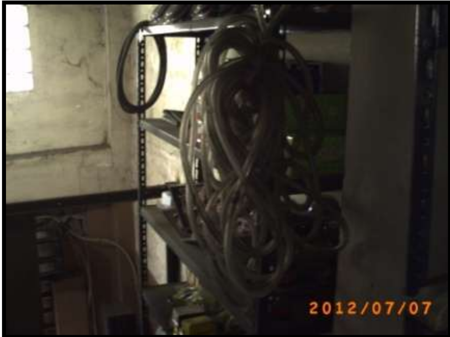
Figura 3. 10: Manguera para agua potable
