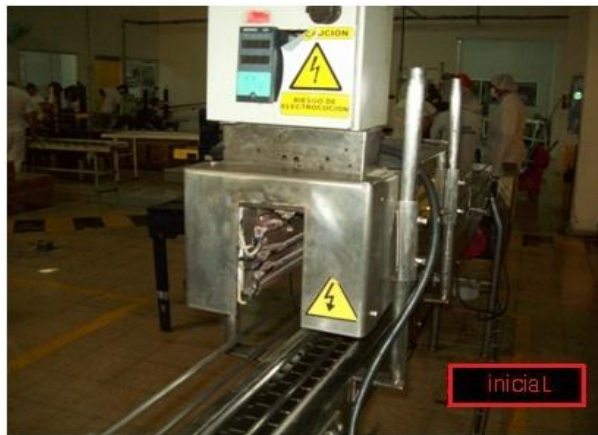
Fig.3.23. Entrada de túnel termoformado
