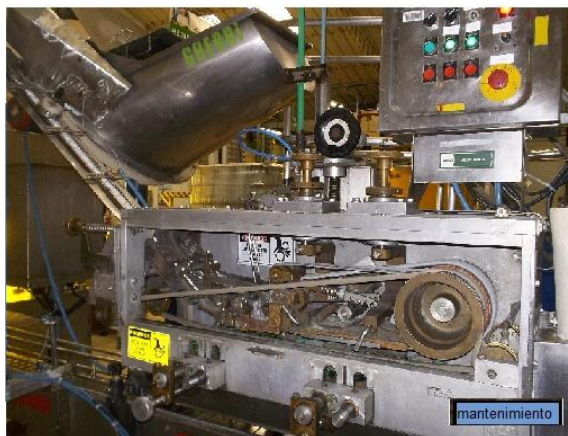
Fig.3.27. Tapadora en mantenimiento
