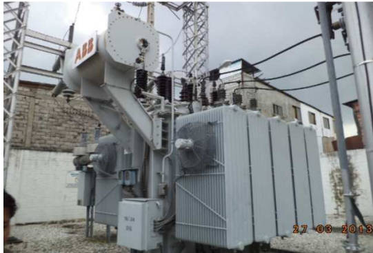
Figura 4 Transformador de la S/E Puerto Liza.
