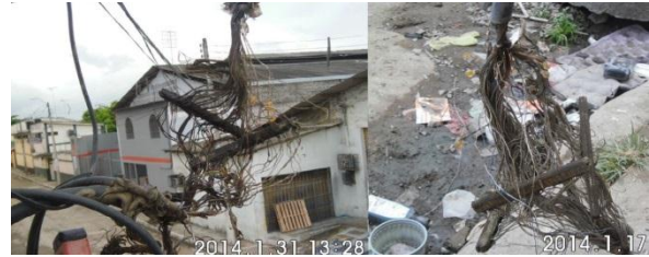
Figura 13. Empalmes a la intemperie.
