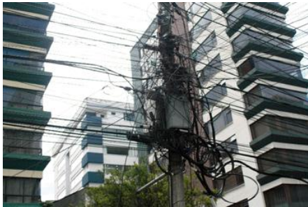
Figura 10. Cableado de datos junto a transformador eléctrico.
