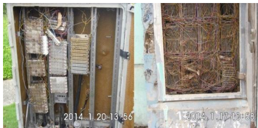
Figura 11. Armarios en mal estado.
