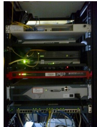
Figura 14. Rack con sus respectivos equipos de telecomunicaciones
