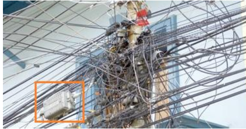
Figura 9. Caja de distribución cerca de cableado eléctrico.
