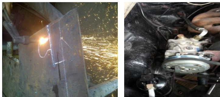
Figura4-16 Proceso de construcci3n de base.
