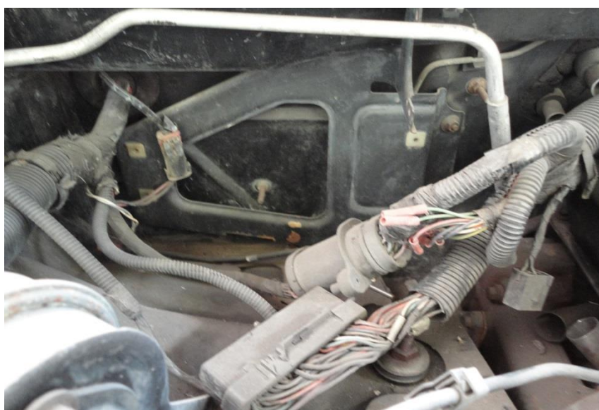
Figura 4.3. Ausencia de la PCM Fuente: Autor
