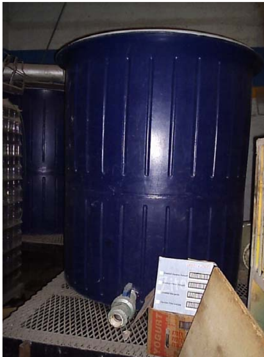
FIG. 2.2 TANQUES DE ALMACENAMIENTO DE AGUA.
