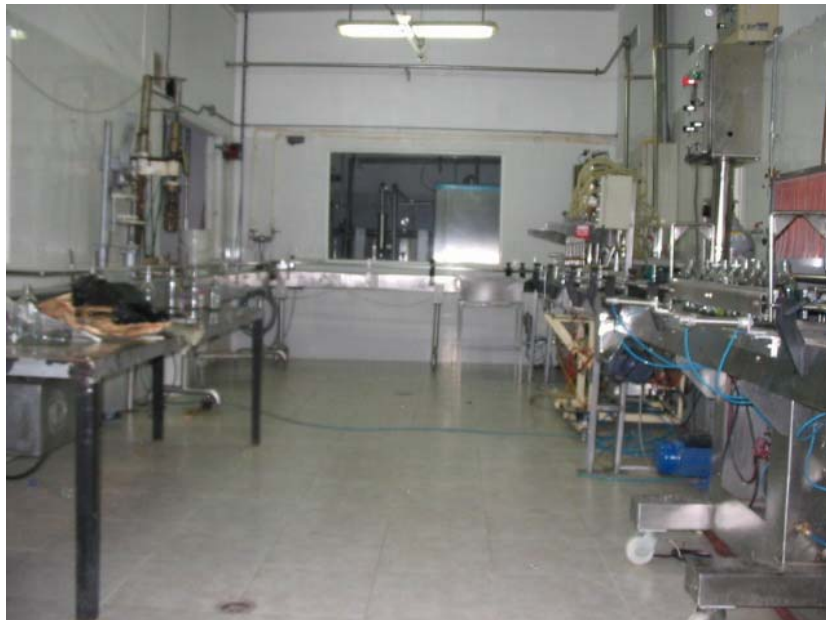
FIG. 2.6 EQUIPOS COLOCADOS EN LA SALA DE LLENADO EN FORMA DE UNA LETRA U.
