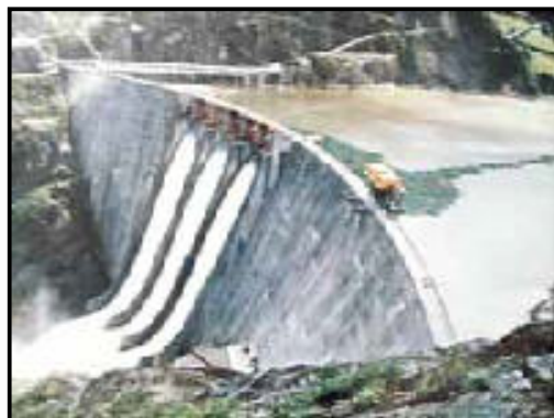
Figura 2-2 Foto de la central hidroeléctrica Paute [10]
