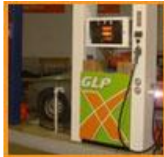
Figura 4.3: Dispensador de combustibles
