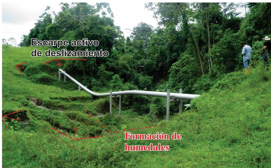
Foto 12. Activos escarpes de deslizamientos para el sitio inestable Pk 83+350 (670.947mE, 10.033.035mN).
