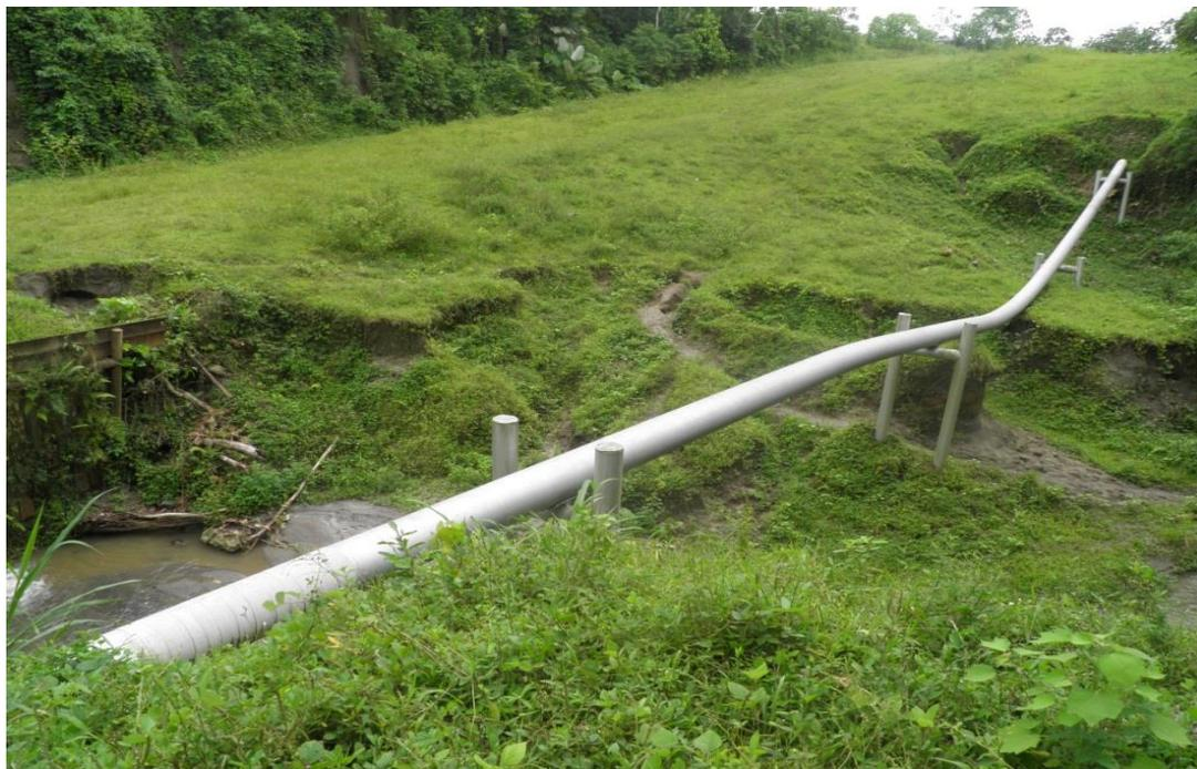
**Foto 14. Estación PK 83+350 que evidencia escarpes de deslizamiento y zona de subsidencia que afecta los soportes de la tubería del poliducto.**
