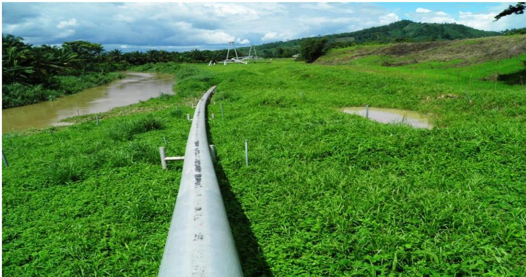
Foto 1. Desplazamiento vertical de la tubería por subsidencia en Pk 47+300.
