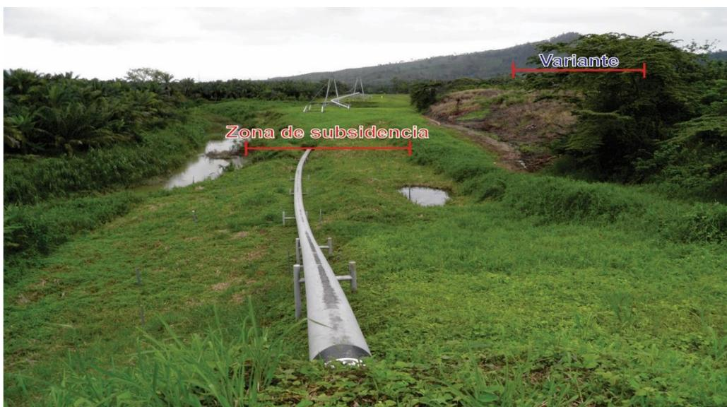
Foto 2. Paisaje geomorfológico del terreno indicando la extensión de la zona de subsidencia y la propuesta para la nueva variante de la tubería del poliducto
