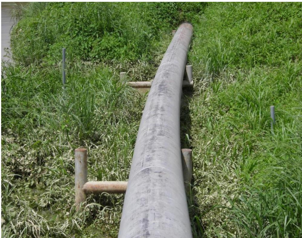
**Foto 3. Desplazamiento de la tubería del poliducto por subsidencia en zona de terraza aluvial inundable. Pk 47+300.**
