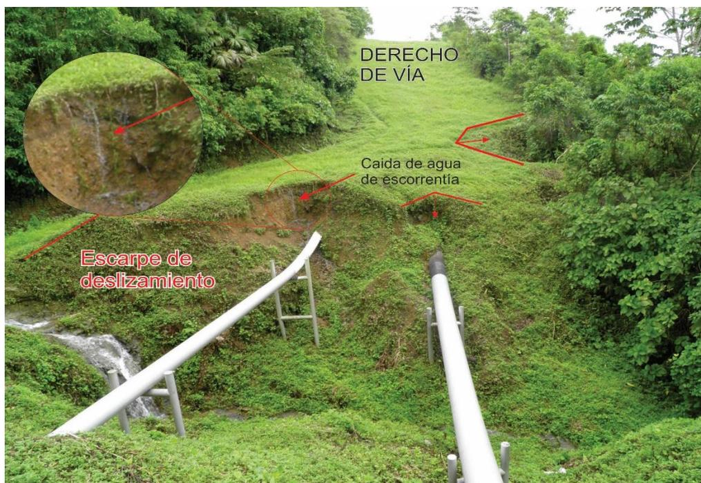
Foto 9. Activos escarpes de deslizamientos para el sitio inestable Pk 57+977 (661.509mE, 10.054.898mN).
