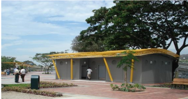
Foto JPG 5: Local de baños.
