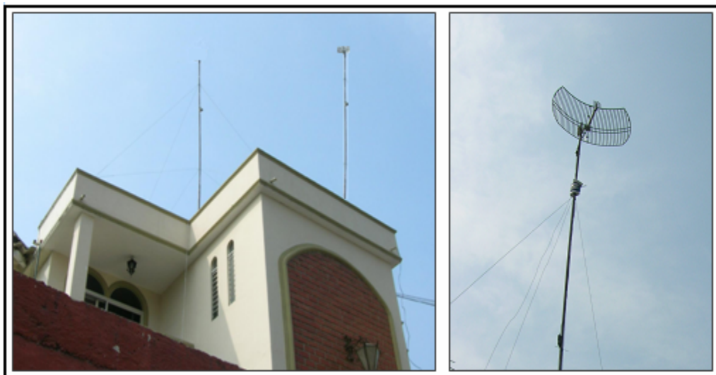
Figura 4.2 Antenas instaladas en sucursal
