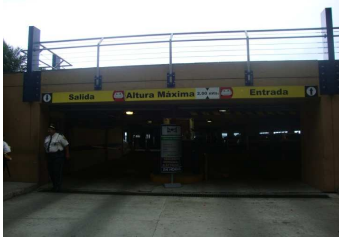
Imagen JPG. 9 Parqueadero
