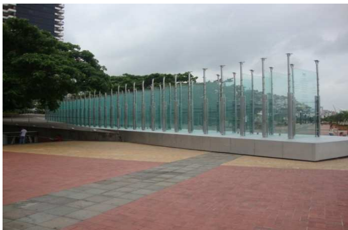
Imagen JPG. 10 Pabellón de los Donantes
