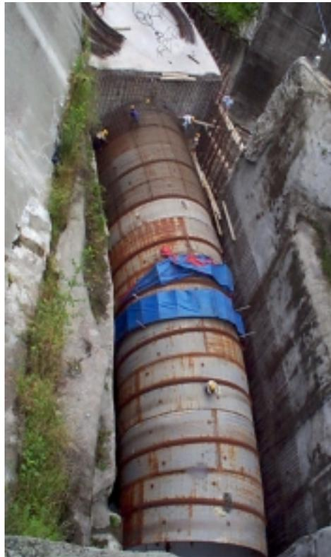
**Fig. 1.8: Revestimiento de la tubería de presión**
