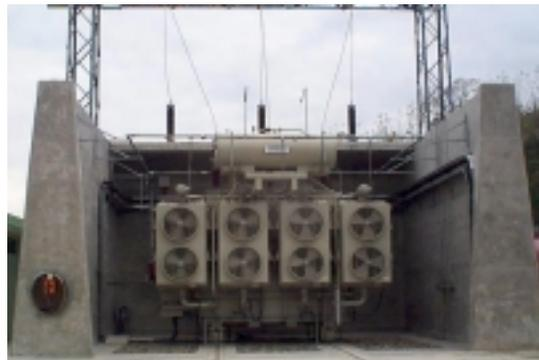
**Fig. 1.21: Transformador de Potencia 85 MVA**
