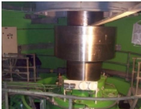
**Fig. 1.16: Eje de la turbina**
