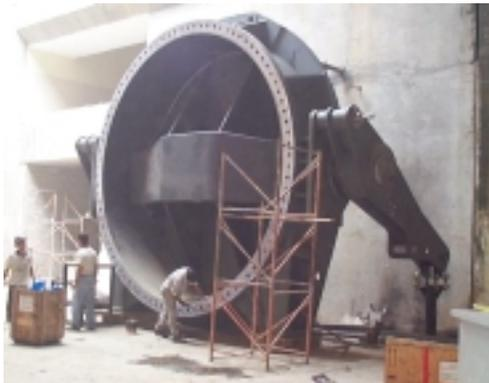
**Fig. 1.13: Válvula mariposa antes de instalación**
