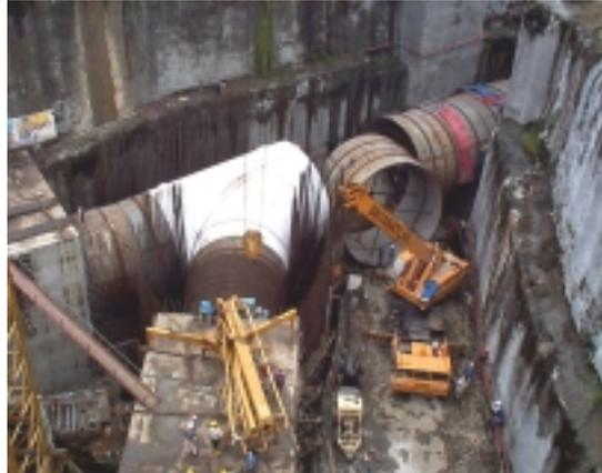
**Fig. 1.9: Derivaciones de la tubería de presión**
