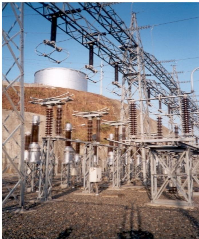
**Fig. 2.23: Seccionador tipo pantógrafo de la central**
