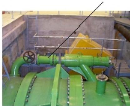
**Fig. 1.12: Válvula by-pass de la válvula mariposa**
