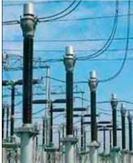
Gráfico 35 Transformadores de corriente
