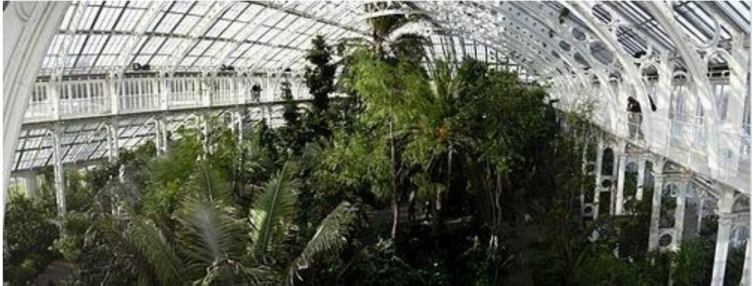
Figura 2.1 - Vista panorámica del interior de un invernadero en los KewGardens de Londres. [3]
