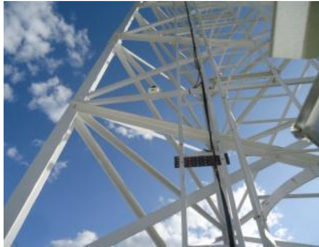
FIGURA 8 Bajante de puesta a tierra
