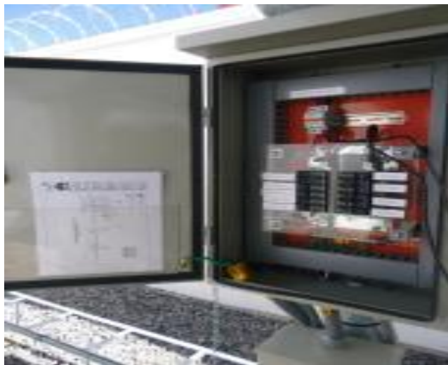
FIGURA 7 Instalaciones de tableros de distribución general
