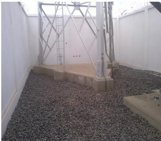
FIGURA 4 Torre auto soportada.
