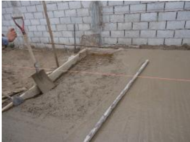
FIGURA 1 Nivelación del terreno
