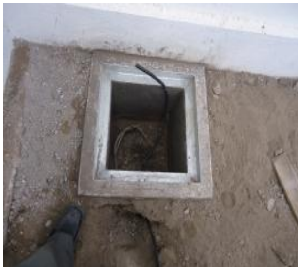
FIGURA 9 Cajas de revisión de puesta a tierra
