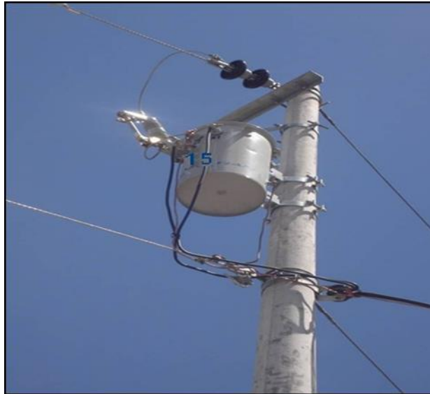
FIGURA 6 Transformador de 15 KVA
