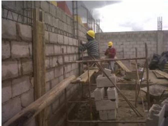
FIGURA 2 Mampostería de bloque
