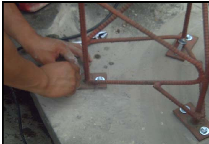
Fig 4.6 Colocación de los Refuerzos de la Torre
