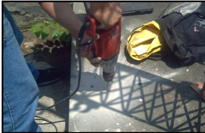
Fig 4.5 Instalación de la Base de la Torre
