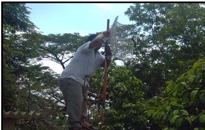
Fig 4.8 Direccionamiento de Antena
