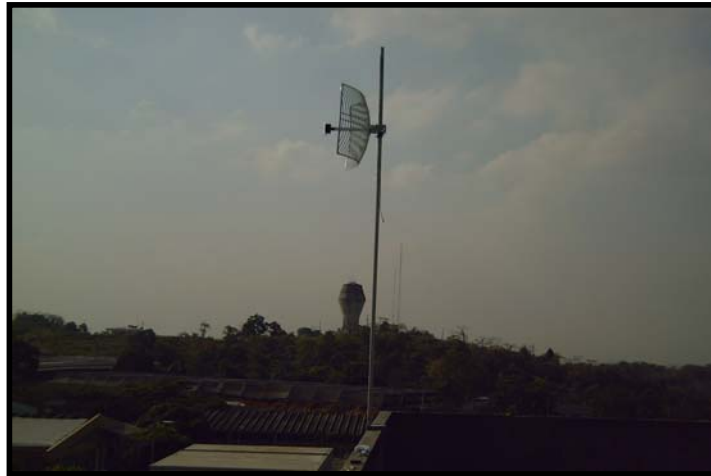
Fig 4.31 Antena en el edificio de Tecnología
