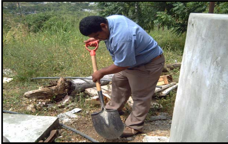
Fig 4.23 Relleno de Tubería Exterior
