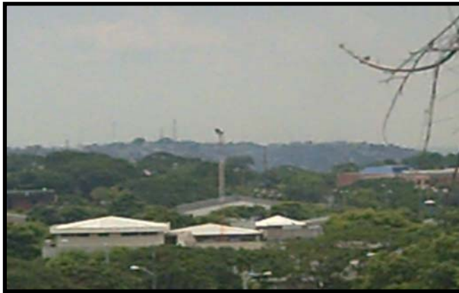
Fig 4.20 Vista del Edificio de Tecnologías
