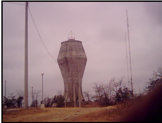
Fig 4.1 Búsqueda de lugar adecuado para la torre
