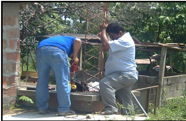
Fig 4.4 Colocación de la Torre
