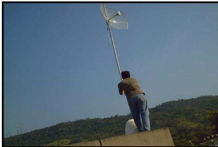
Fig 4.30 Direccionamiento de la Antena
